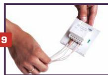
**9.** Установите терморегулятор на стену, подведите к нему два дополнительных провода ВВГнг или ПВЗ 1x2,5 от стержневого мата и подключите к нужным клеммам (схема подключения есть на каждом терморегуляторе). Произведите кратковременное (5 мин) включение систем для проверки их работы.
