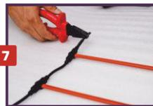
**7.** У последней полосы стержневого мата изолируйте оба конца мата: установите термоусадочную трубку на оголенный провод (на 2 см) и усадите ее строительным феном. Обожмите конец термоусадки пассатижами.
