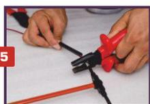
**5.** Подготовьте дополнительный провод сечением 2,5 мм (ВВГнг или ПВЗ 1x2,5), чтобы соединять между собой полосы мата, а также для соединения мата с терморегулятором (провод приобретается отдельно).
