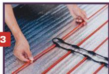
**3.** В месте разворота полосы карбонового мата разрежьте один соединительный провод и поверните полосу в нужном направлении.
