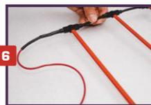
**6.** Гильзой соедините два провода, зажмите ее пассатижами и закройте соединение термоусадочной трубкой (нагрейте ее, зажав гильзу, горелкой или строительным феном).
