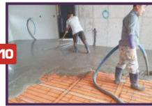
**10.** Залейте стяжку пола: толщина 2–5 см или уложите слой плиточного клея толщиной 1 см. Включение стержневого мата возможно только после полного высыхания стяжки: стяжка полностью высыхает в течение 28 дней, а плиточный клей в течение 5–7 дней.
