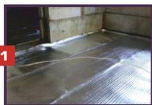
**1.** На чистую и ровную поверхность черного пола по всему периметру помещения уложите пенополистерол 50 мм и закрепите его дюбелями для пенопласта (зонты). Или застелите весь пол теплоотражающей лавсановой подложкой для теплого пола, толщиной 3-5 мм. Стыки подложки скрепите монтажным скотчем.
