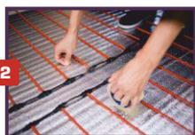
Если монтаж будет в тонкий слой плиточного клея (от 1 см), то теплоизоляция не укладывается (может потрескаться плиточный клей).
